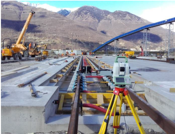
Abbildung 7: GML im Einsatz.
