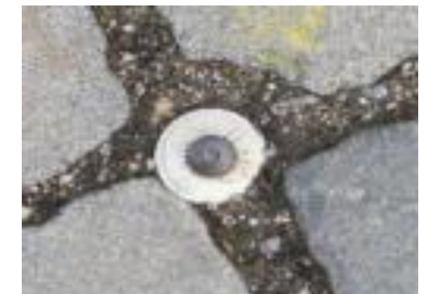
Rohr mit plastischer Kappe und Nagel
