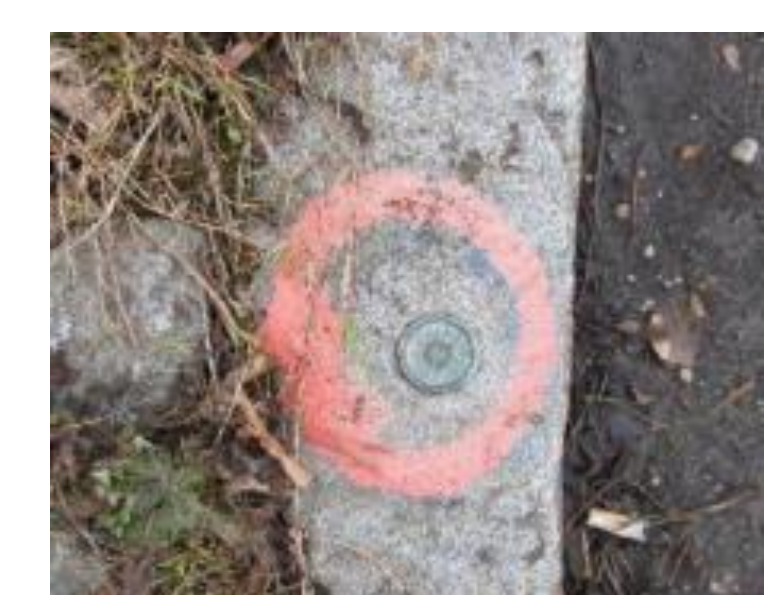
Bolzen im Bordstein
